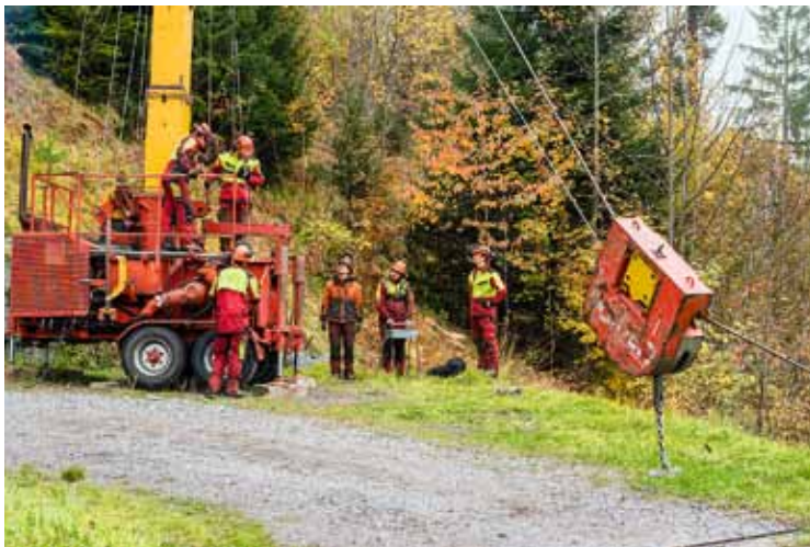
Für den Bergwald erfunden: Am Laufwagen (r.) des Seilkranes werden die Stämme befestigt.
