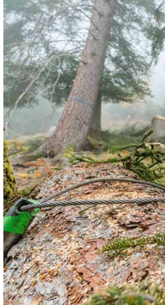
Bereit für den Luft-Transport: Stefan Thöny wickelt die stählernen Anhängestruppen ums Holz und klinkt sie in die Verschlüsse am Seil des Krans ein.
